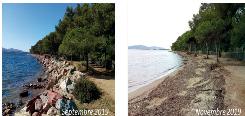
Figure 10. Trait de côte avant (septembre 2019) et après (novembre 2019) le désenrochement le long du littoral des Vieux Salins (source TPM).
